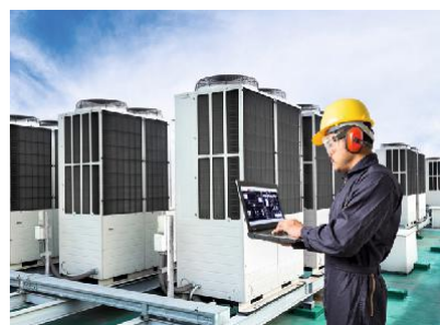
建筑管理系统
